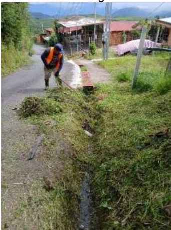
Quebrada Honda Limpieza y pintura de puentes
